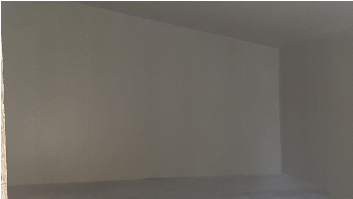
Gårdshus med cykel garage och undercentral. Vi väntar på special panel till det här huset, bränd panel ska det vara.
